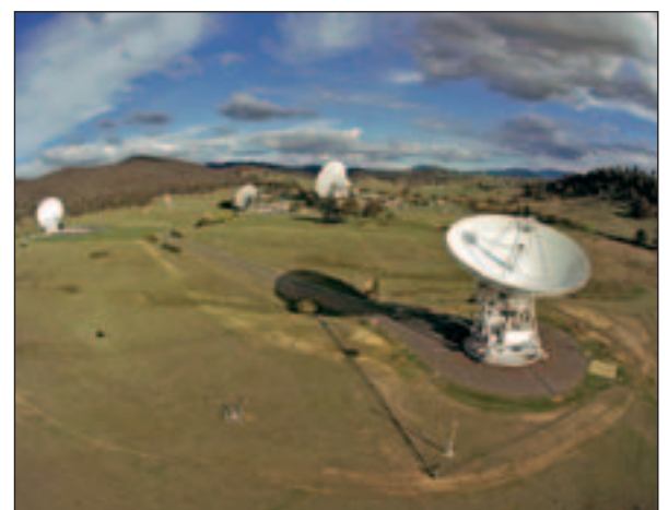
3. Het grondstation in Canberra, Australië, van het Deep Space Network (DSN) van de NASA, een van de stations die de flyby's van enkele ruimtesonde waarnamen (de NEAR-passage werd voornamelijk met dit station gevolgd). Andere stations van het DSN bevinden zich in Californië (Goldstone) en Spanje (bij Madrid). Deze plaatsen zijn met tussenruimten ongeveer 120^\circ over de aardbol verdeeld, zodat altijd een van de stations contact kan hebben met een ruimtevaartuig als dit niet te dichtbij is. (Foto: NASA)
